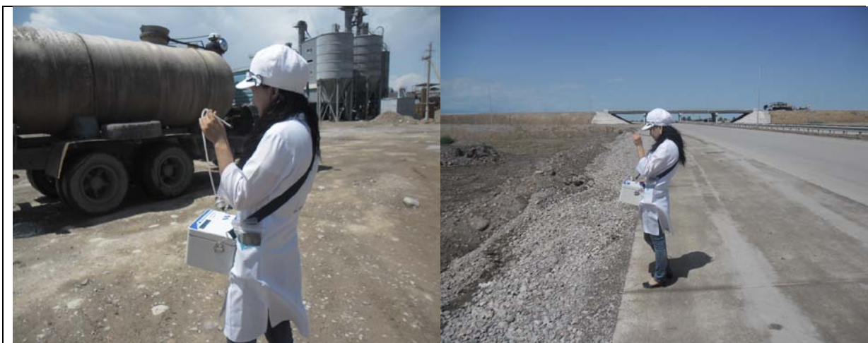
Мониторинг качества атмосферного воздуха на Бетонном заводе (левая сторона) и участка дороги Км 328 +300 недалеко от Аспары (правая сторона)
