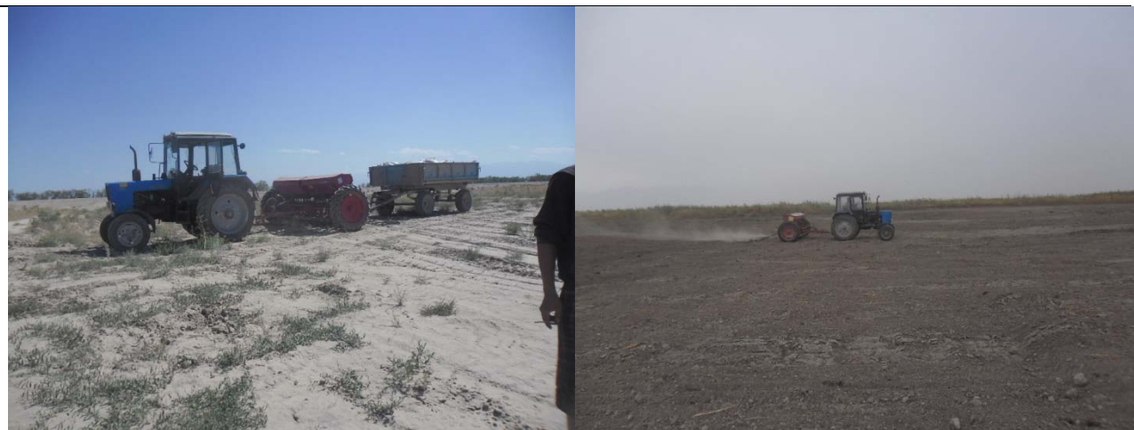
Работы по рекультивации карьер – Аспара 1 (слева) и Аспара 2 (справа)
