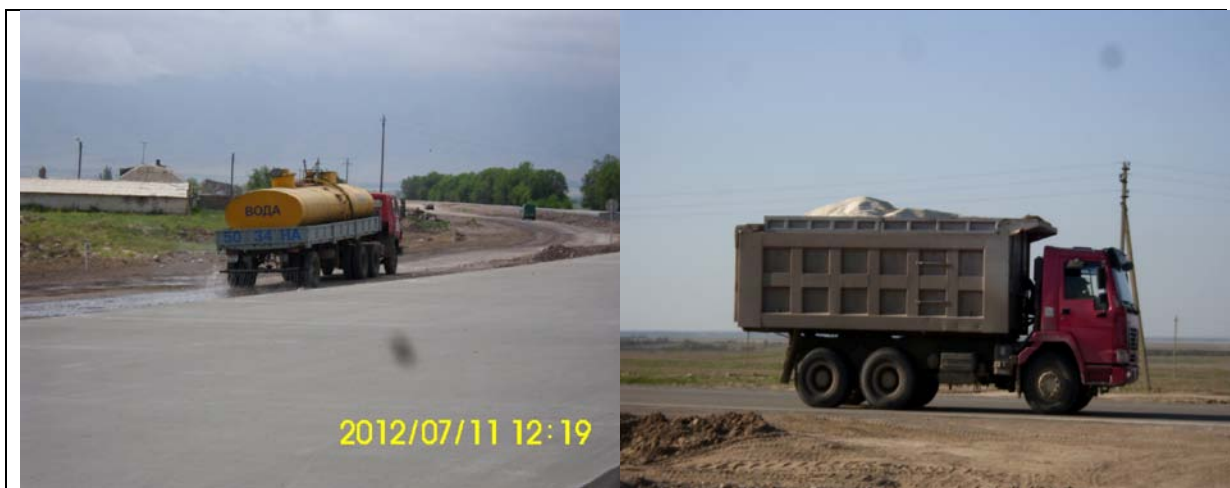
Мероприятия по предотвращению пыли (слева) и покрытие сыпучих материалов брезентом во время транспортировки (справа)
