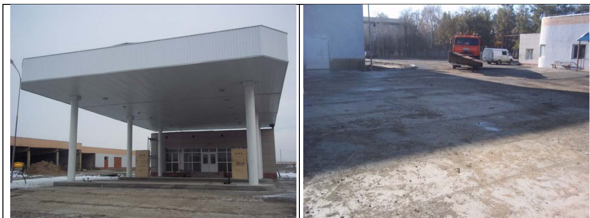
ДЭУ-34, Автозаправочная станция – Технологическое оборудование (бензонасосы) (слева), Благоустройство, цементно бетонное покрытие (справа)
