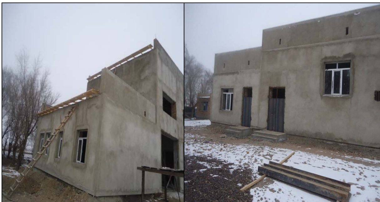
ДЭП в с. Отар – Ремонтная мастерская – кровля
