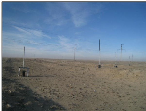
Рисунок 11. Газопровод вблизи проектной дороги
