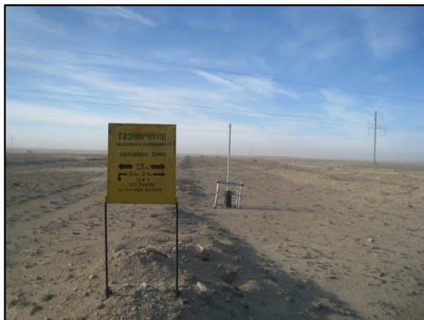
Рисунок 10. Газопровод вблизи проектной дороги
